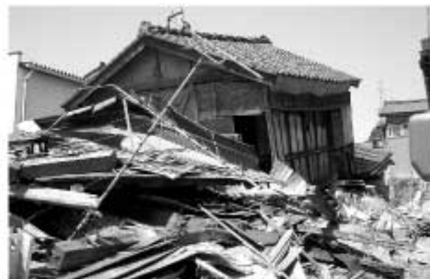
倒壊家屋が続く柏崎市内
