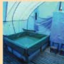
浴室内部（鉄パイプで組み、ビニールシートを張った浴槽。更衣スペースは通路に）
