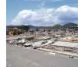
戸建て住宅に被害の大きい北部
