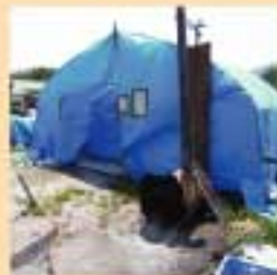
仮設浴室（男女別）手前のドラム缶ボイラーで薪を燃す。ビニールハウスの骨を利用。
