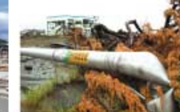
被害の大きい関上地区
